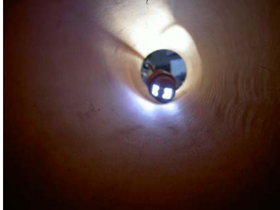
Ingresso di una telecamera in tubazione
