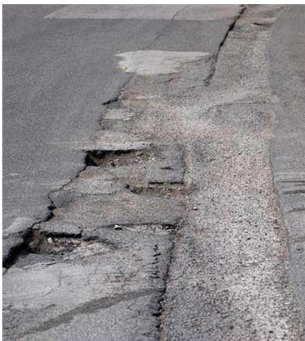
Rottura del manto stradale
