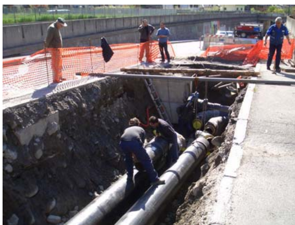
Posa di tubi del teleriscaldamento
