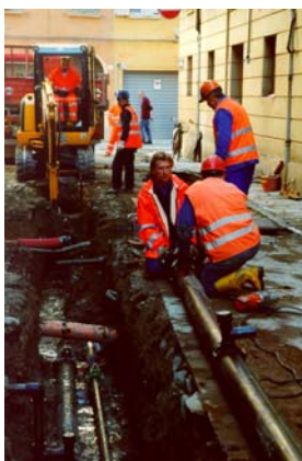
Intervento di manutenzione straordinaria sui sottoservizi
