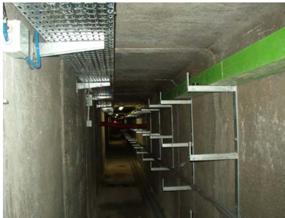
Cunicolo tecnologico in fase di approntamento
