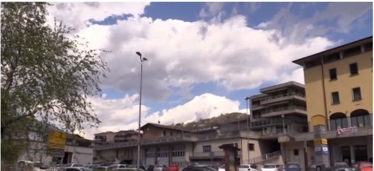
Le nuove lampade a led recentemente installate nel Comune di Cene
