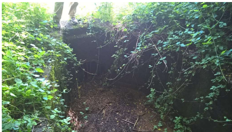
Figura 19 - Codice 03016070_0064, tombotto parzialmente ostruito da detriti ubicato al di sotto della S.p. n.40
