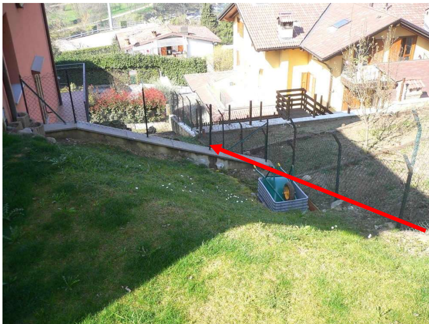
Figura 12_Loc. Via Case Sparse: punto di passaggio del collettore fognario sottodimensionato
