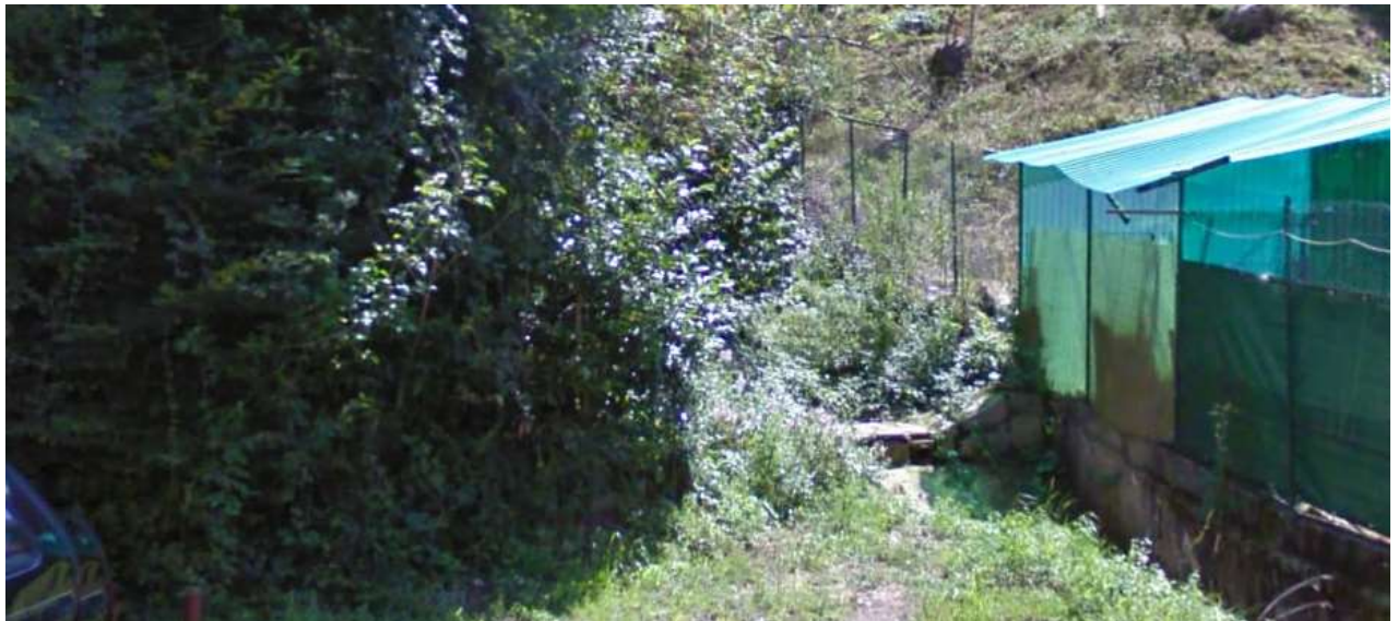
Figura 26- Tratto terminale di Via Ronchi in corrispondenza della tombinatura
