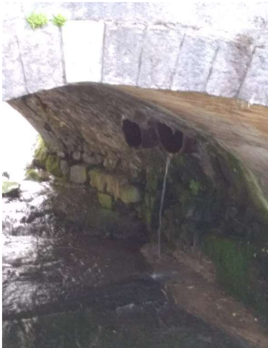
Figura 22-Immissione della valle nel T. Doppia posto sotto l'arcata del ponte lungo Via Bernardo Fanti
