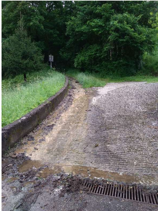
Figura 19-scorrimento delle portate liquide scolanti lungo la strada e nel tratto di sentiero prossimo alla valle
