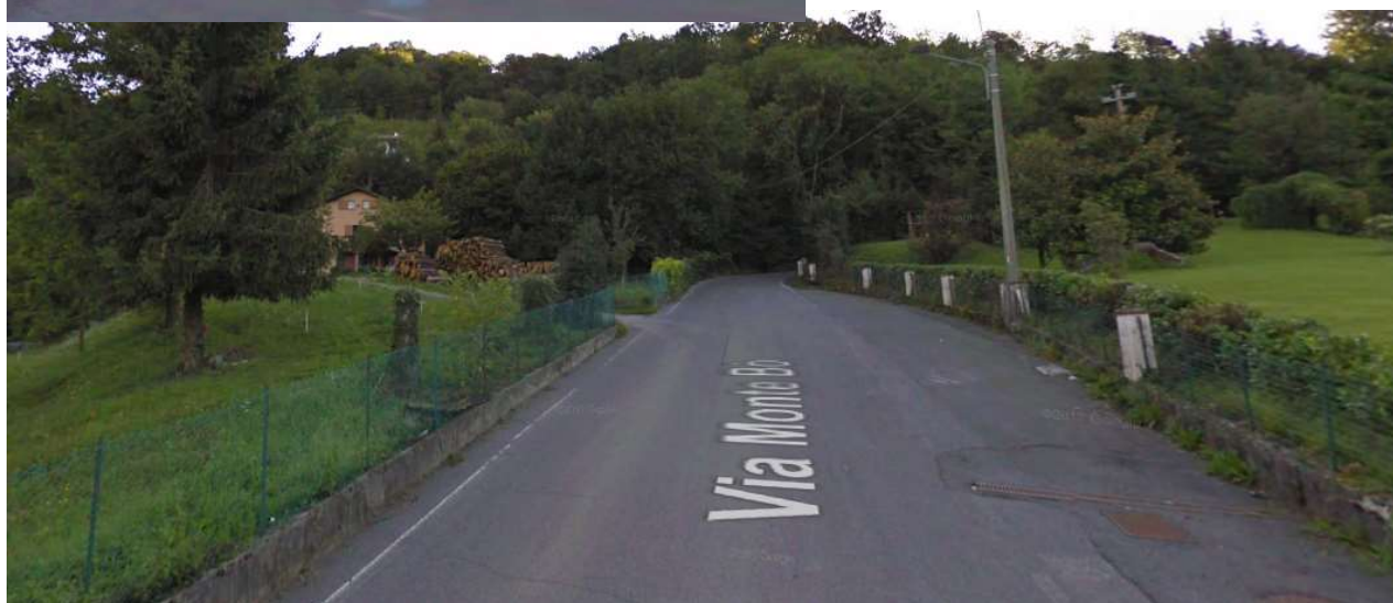
Figura 24- Tratto di valle intubato lungo Via Monte Bo
