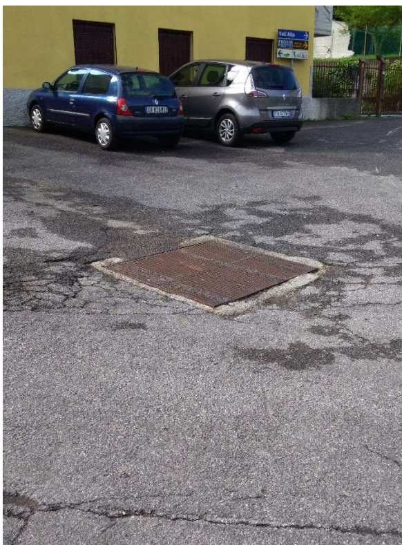
Figura 15- Tratto di valle prossimo all'abitato e particolare della griglia di raccolta delle acque sopra la tombinatura
