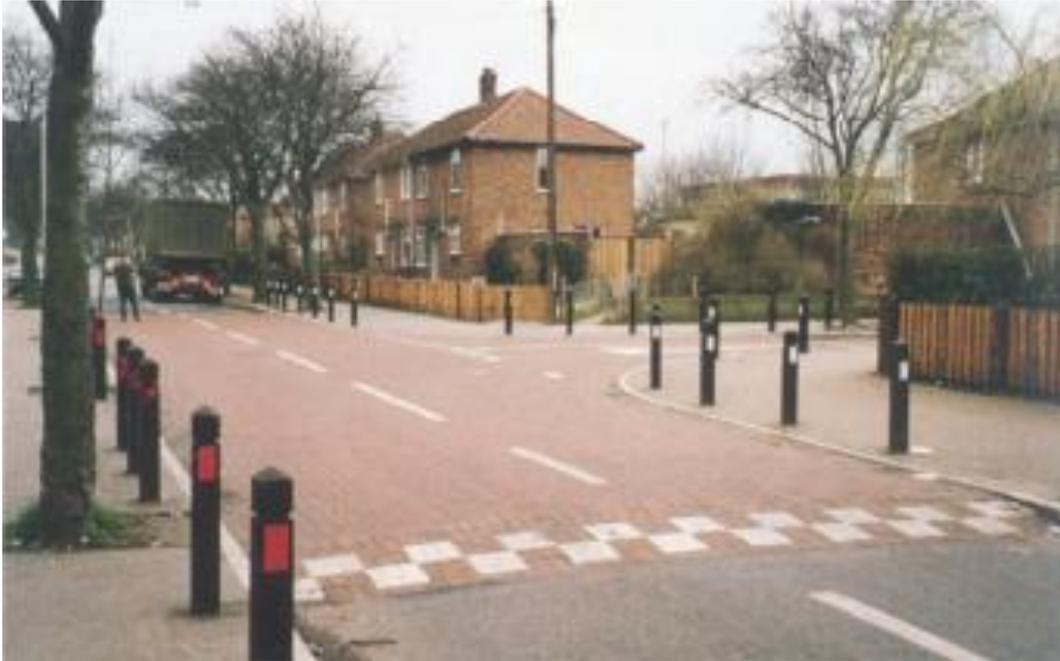
*Messa in sicurezza dell'intersezione e degli attraversamenti pedonali tramite sopraelevazione dell'intera area*
