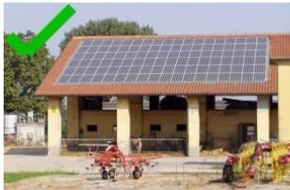
Gli impianti integrati o parzialmente integrati nei tetti/coperture degli edifici devono avere e lo stesso orientamento della falda e possibilmente la stessa inclinazione, in modo che i componenti dell'impianto non modifichino la sagoma degli edifici.
