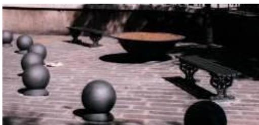
L'installazione di fittoni (dotati di tacche riflettenti per la visione notturna, 4-5 elementi ad un passo di 1,5 m, ad una distanza di 1,2 m dal muro) permette di mettere in sicurezza i pedoni; attraverso un restringimento della carreggiata utile, i fittoni inducono un rallentamento dei veicoli.
