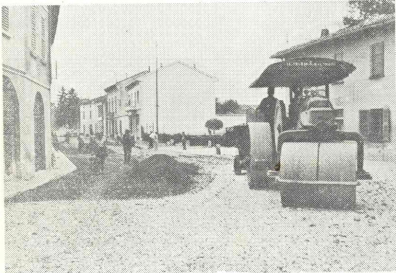
Sono in fase ormai avanzata i lavori per il rifacimento e la pavimentazione delle Vie Caldara e XI Febbraio.
