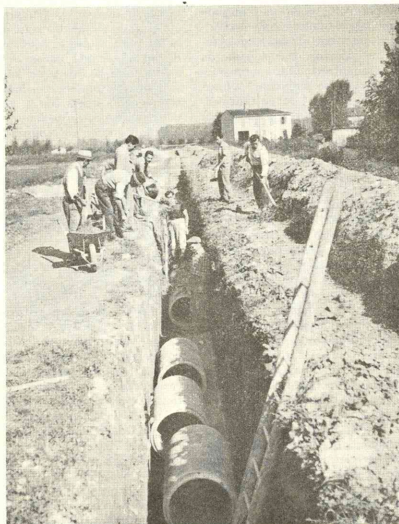
CANTIERE DI LAVORO - Posa di tubi di cemento per la costruzione della [fognatura sulla via allacciante] Piazza Marconi alla Via M. Nero
