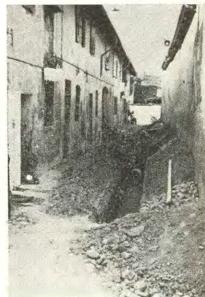
Vicolo Diritto servito dalla fognatura I lavori in fase di ultimazione
