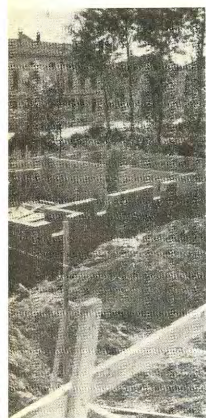
Corso per la costruzione della dei Carabinieri
