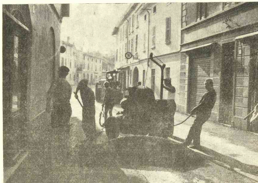
Via XX Settembre - La sistemazione della sede stradale con trattamento bituminoso
