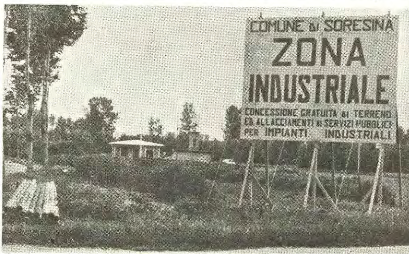
La zona industriale messa a disposizione dal Comune. Sullo sfondo lo stabilimento Steffen in fase di avanzata costruzione
