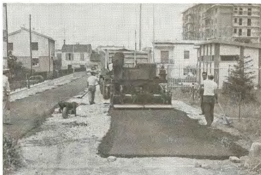
Via dello stadio - Lavori di pavimentazione.
