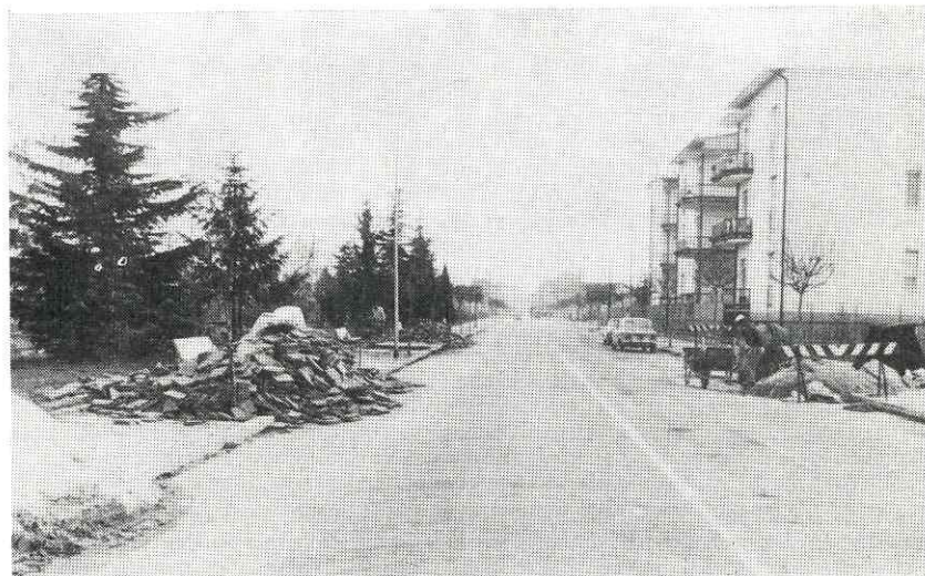
VIA GRAMSCI - I lavori per la pavimentazione dei marciapiedi
