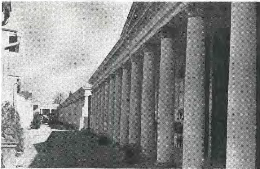
CIMITERO URBANO - Uno scorcio del nuovo porticato di levante
