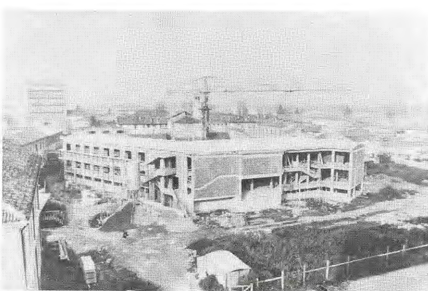
PIAZZA ITALIA - La realizzazione del primo lotto dei lavori, in fase di ultimazione
