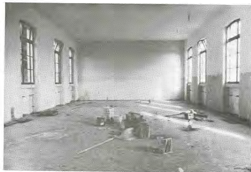
Sono in fase di ultimazione i lavori di costruzione della nuova palestra presso le Scuole Elementari di viale Matteotti.
