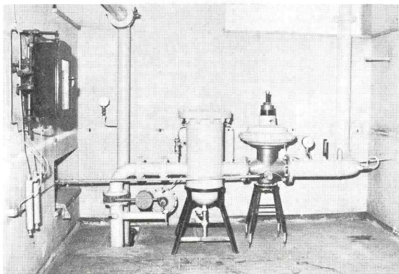
Interno della cabina di via Trigolo. Veduta generale delle apparecchiature, per riduzione di 1° salto da 40 Ate a 3,5 Ate sono ben visibili i filtri scambiatori di calore; i riduttori con monitor pilotati automatici; valvola di sfioro a contrappeso).
