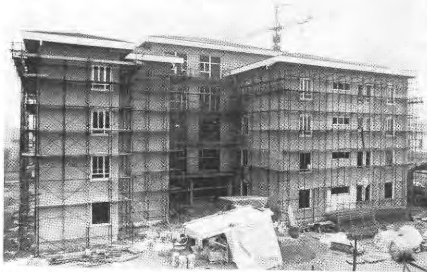
Via Gramsci - In fase di ultimazione i lavori per la costruzione della nuova sede della Casa di Riposo.
