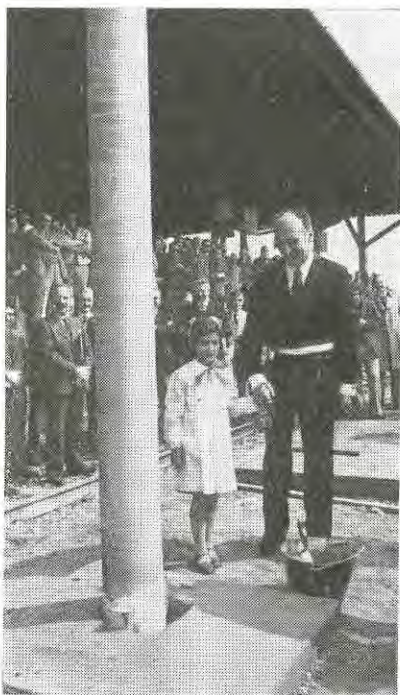
Il Sindaco e la madrina alla cerimonia della posa del primo palo per l'elettrificazione della linea ferroviaria.
