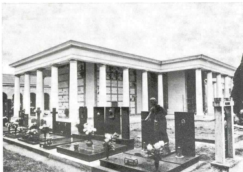
Cimitero urbano - Il nuovo padiglione del campo H, recentemente ultimato.
