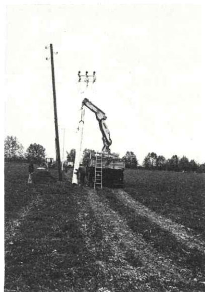
Una fase dei lavori per il rifacimento delle linee elettriche esterne.
