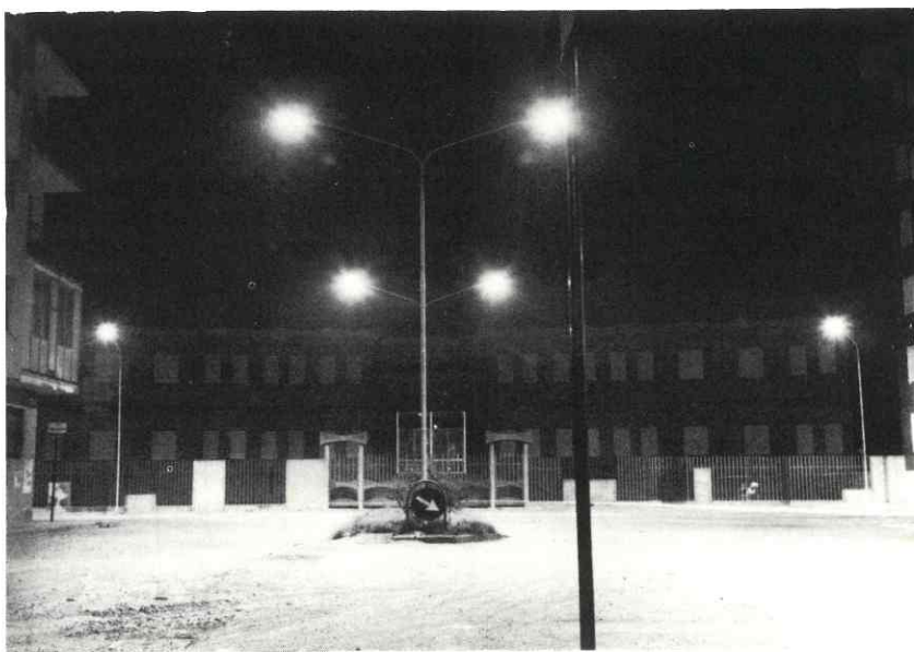
Il nuovo impianto di illuminazione in piazza Italia.
