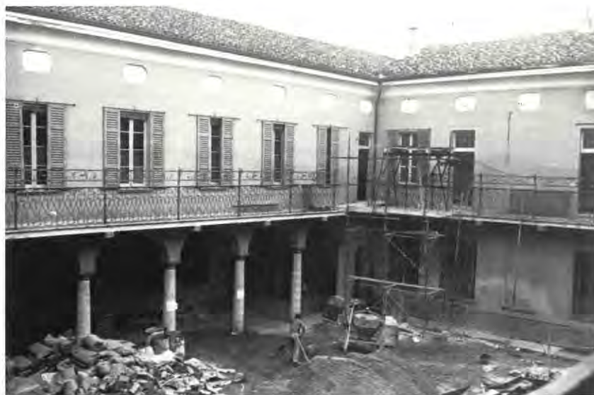
Ex Casa di Riposo: i lavori in corso nell'interno per la ristrutturazione dei locali.
