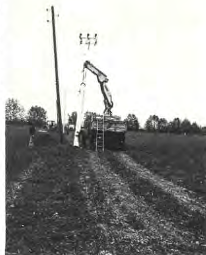
Una fase dei lavori per il rifacimento delle linee elettriche esterne.
