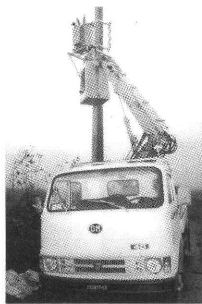
Cabina di trasformazione su palo derivata da linea a M.T. in fase di allestimento. È visibile il trasformatore da 15.000/380 V. da cui si dipartiranno le linee di distribuzione a bassa tensione.
