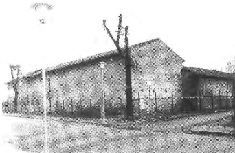
Cascina Malatera - L'immobile da ristrutturare.
