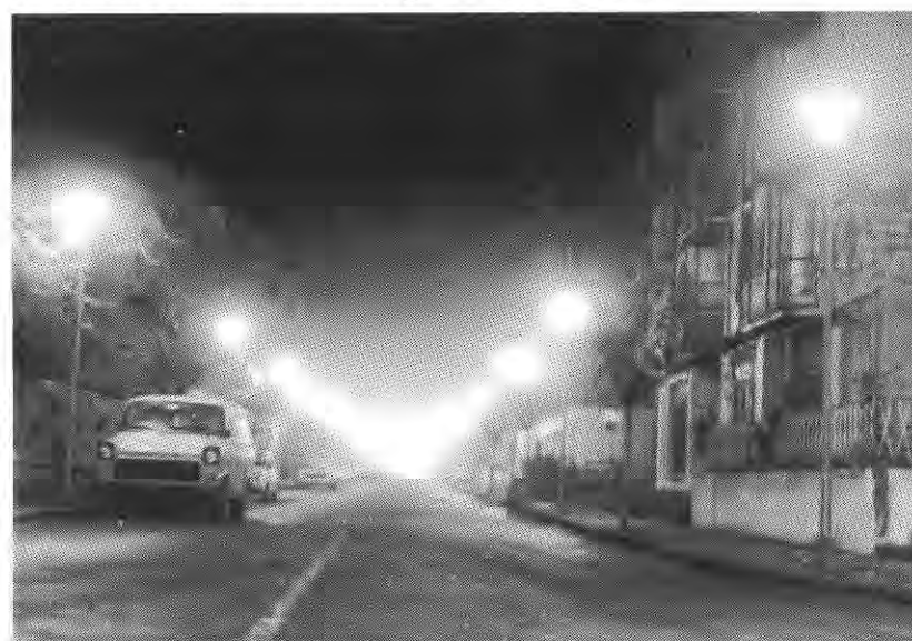
Visione notturna della via Barbo dopo la sostituzione delle lampade a vapori di mercurio con altre a vapori di sodio ad alta pressione.
