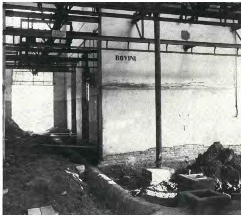
Macello Comunale - I lavori in corso per la manutenzione straordinaria delle strutture.
