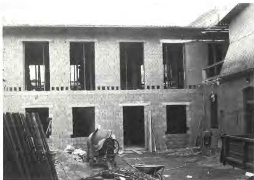
In Via Zucchi Falcina, la costruzione dell'archivio e del magazzino.
