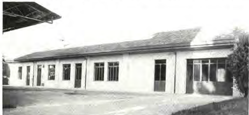
Intervento di recupero all'interno della sede aziendale di Via Cairoli - come si presenta il vecchio porticato, dopo la completa ristrutturazione che ha consentito di ricavare una nuova officina, laboratori vari, locale d'attesa con servizi per il Personale, una ampia autorimessa ed altri magazzini, oltre ad un vasto sottotetto fruibile per deposito materiali.
