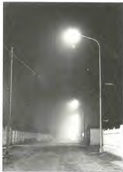
Via Muzio da Soresina - rifacimento ed ampliamento dell'impianto di illuminazione; i centri luminosi posati sono 14 (contro i 7 di prima) con lampade da 150 W al sodio alta pressione.
