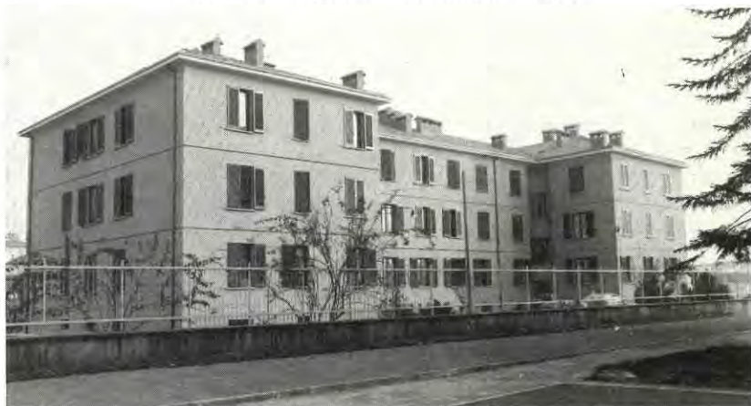
Via 4 Novembre - Gli alloggi comunali ristrutturati.
