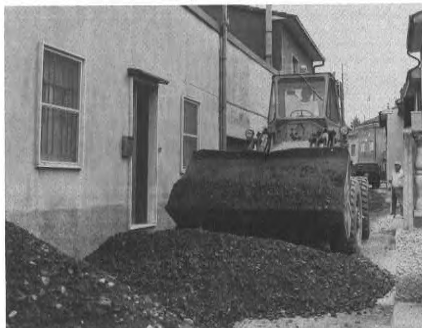
Via De Stefani - nuova pavimentazione
