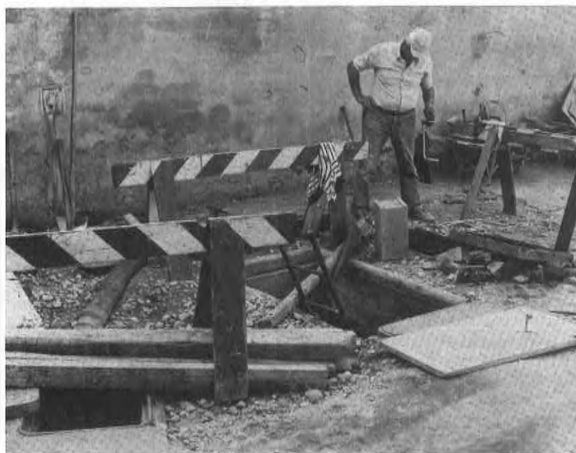
Via Pasini - sistemazione rete fognante
