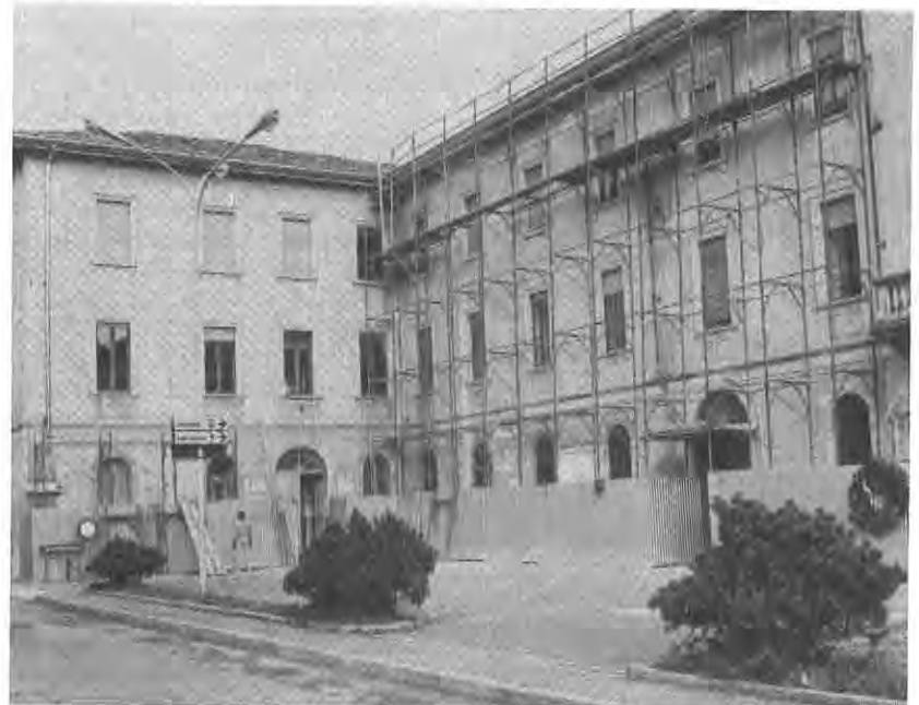
Palazzo Comunale - ristrutturazione
