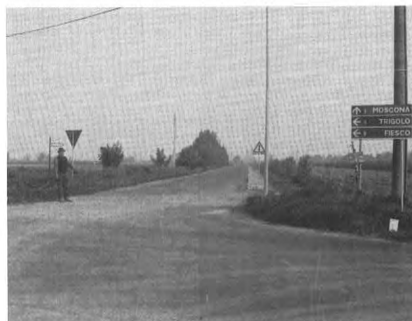
Allargamento della sede stradale per la frazione Moscona.
