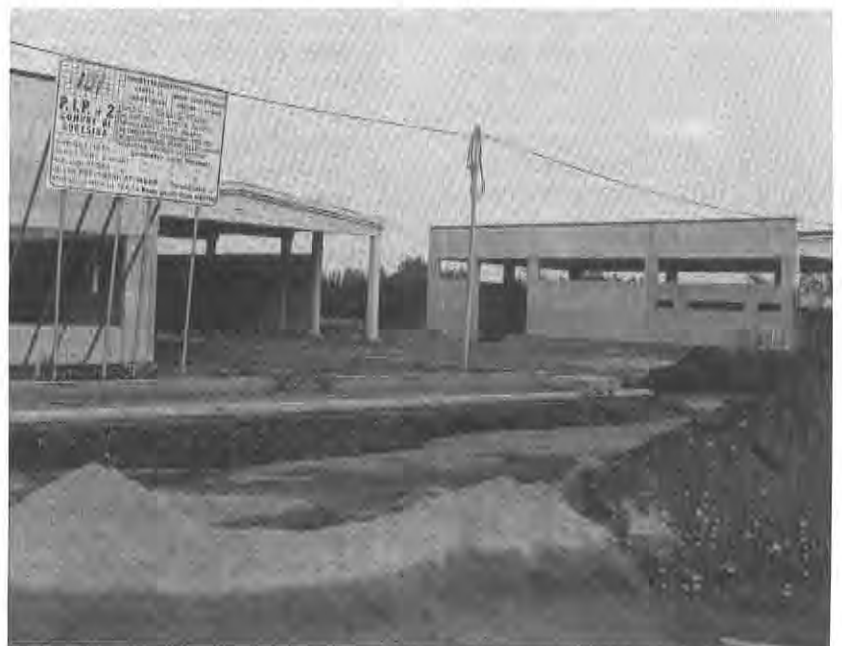
Zona industriale (P.I.P. 2) opere di urbanizzazione.
