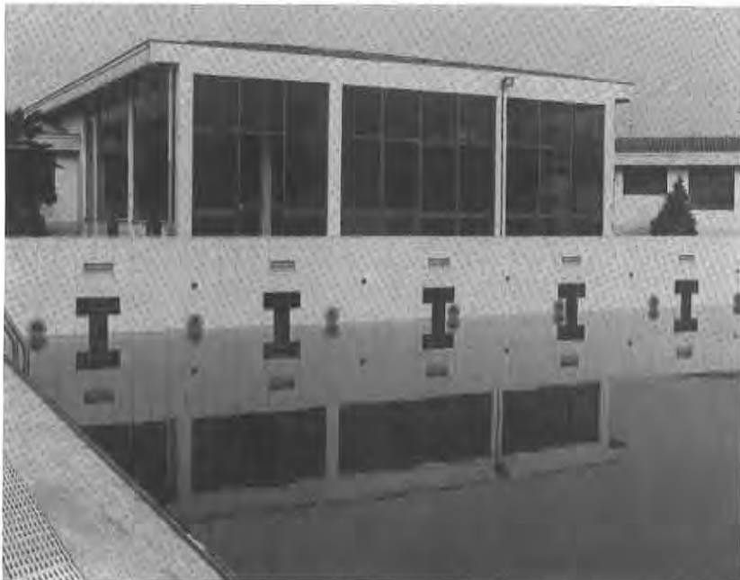
Piscina Comunale - nuovo rivestimento vasca.
