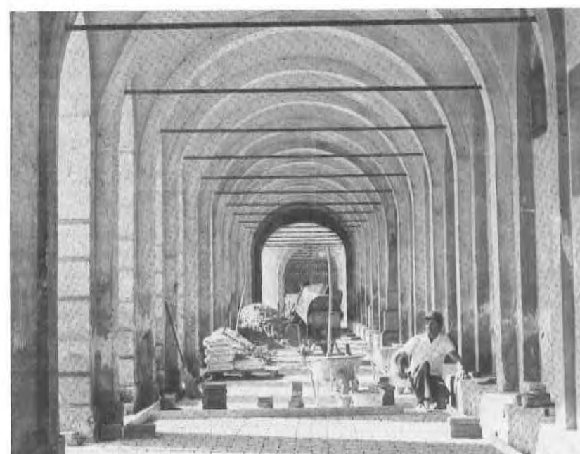
Cimitero del Voghera - rifacimento pavimento.
