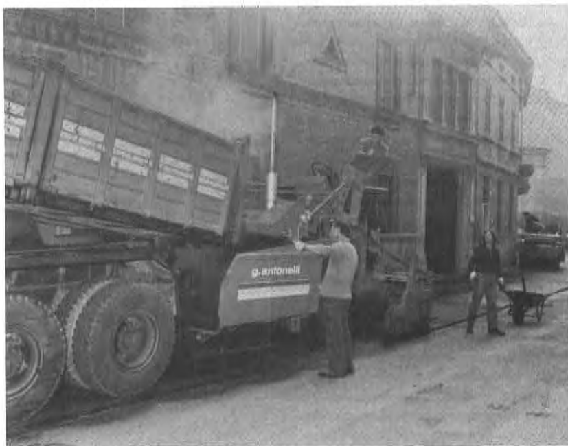
Via Filodrammatici - nuova pavimentazione.
