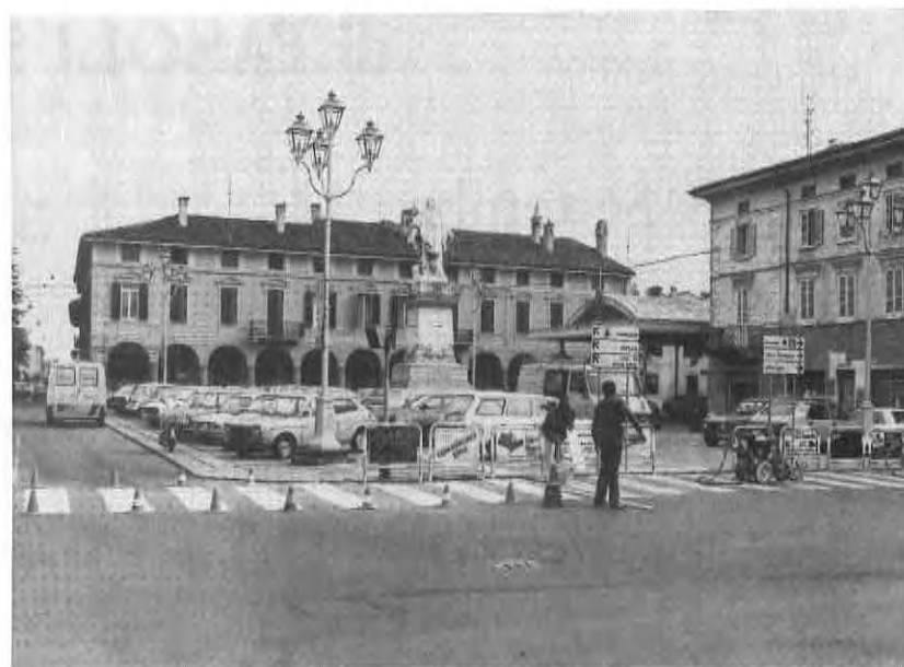
Piazza Garibaldi - rifacimento segnaletica.
