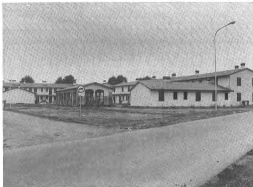
Ristrutturazione cascina "Malatera" - predisposizione n. 30 alloggi popolari.
