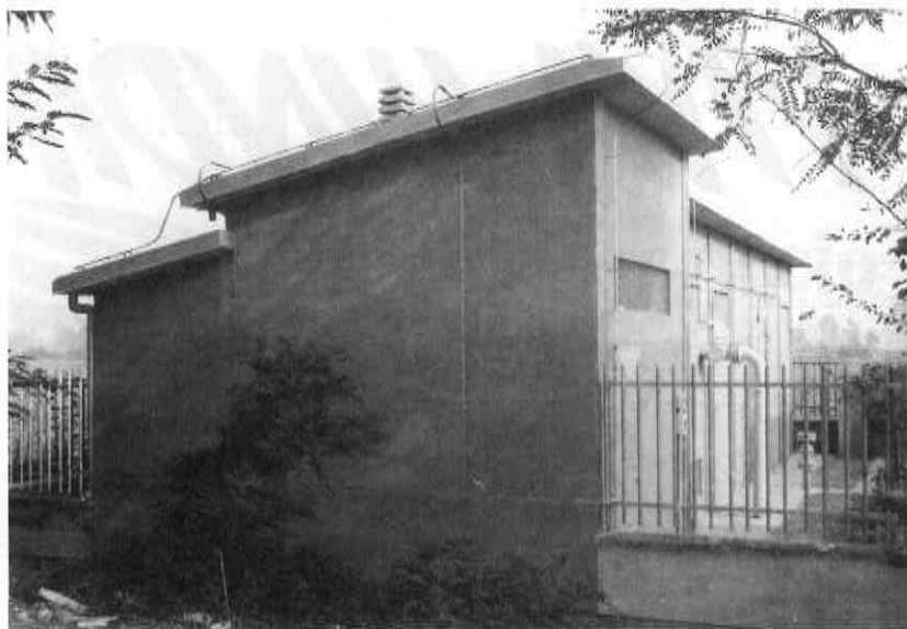
Cabina gas "Casirano": modifica ed ampliamento della parte muraria.
