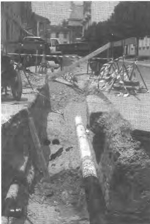
Interramento linee elettriche e posa nuova condotta gas in via Matteotti.
