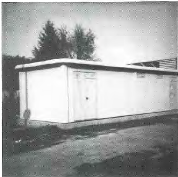
Nuova cabina elettrica di trasformazione di Via Guida.
