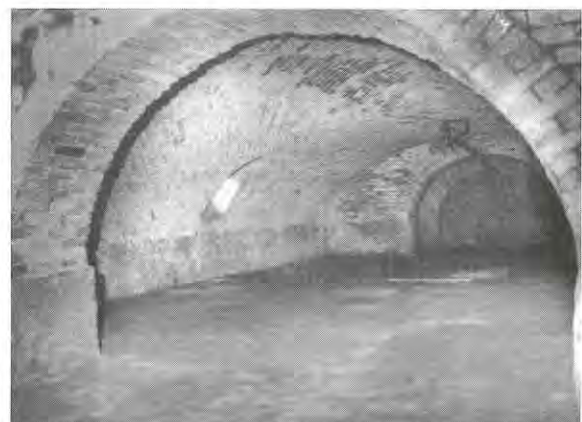
Cantina sala del Podestà: futura sede dei locali della mostra d'arte permanente.
