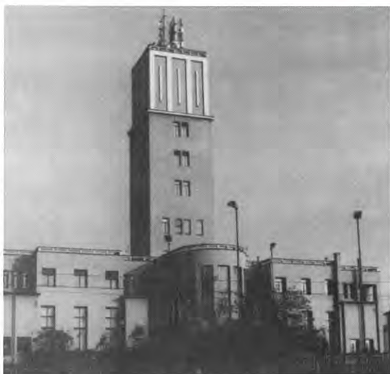
Torre Civica - lavori per l'eliminazione delle barriere architettoniche.
