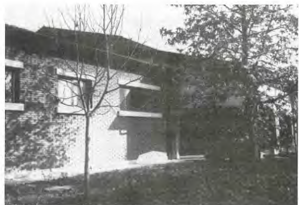
Asilo nido: impianti messa a norma VV.F.
