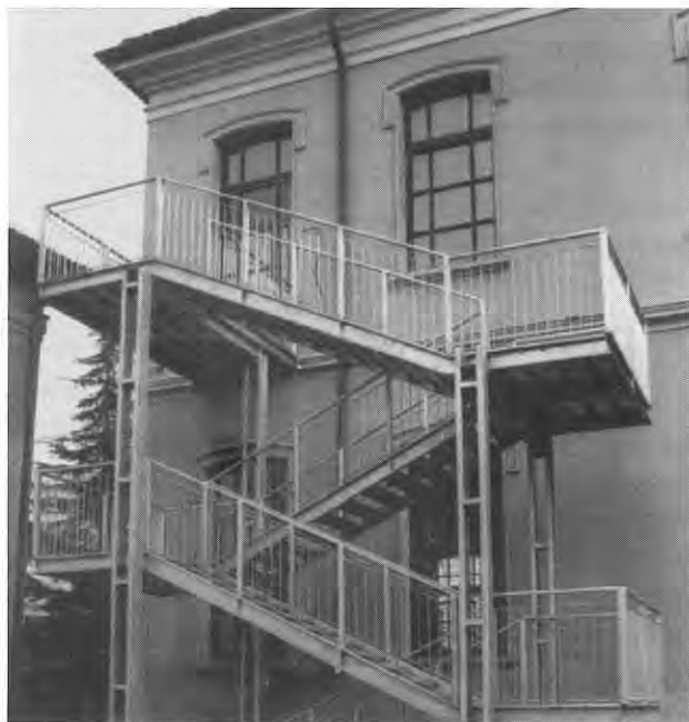
Scuole elementari - nuove scale di fuga a norma VV.F.
