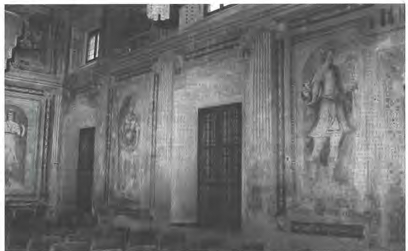
Sala del Podestà: ultimazione dei lavori di restauro delle pitture murali.
