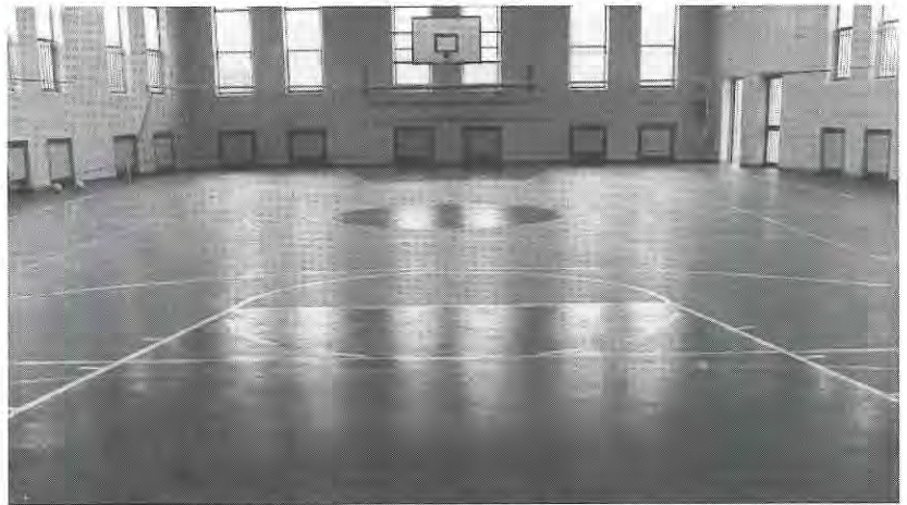
Nuova pavimentazione della palestra della scuola media.
