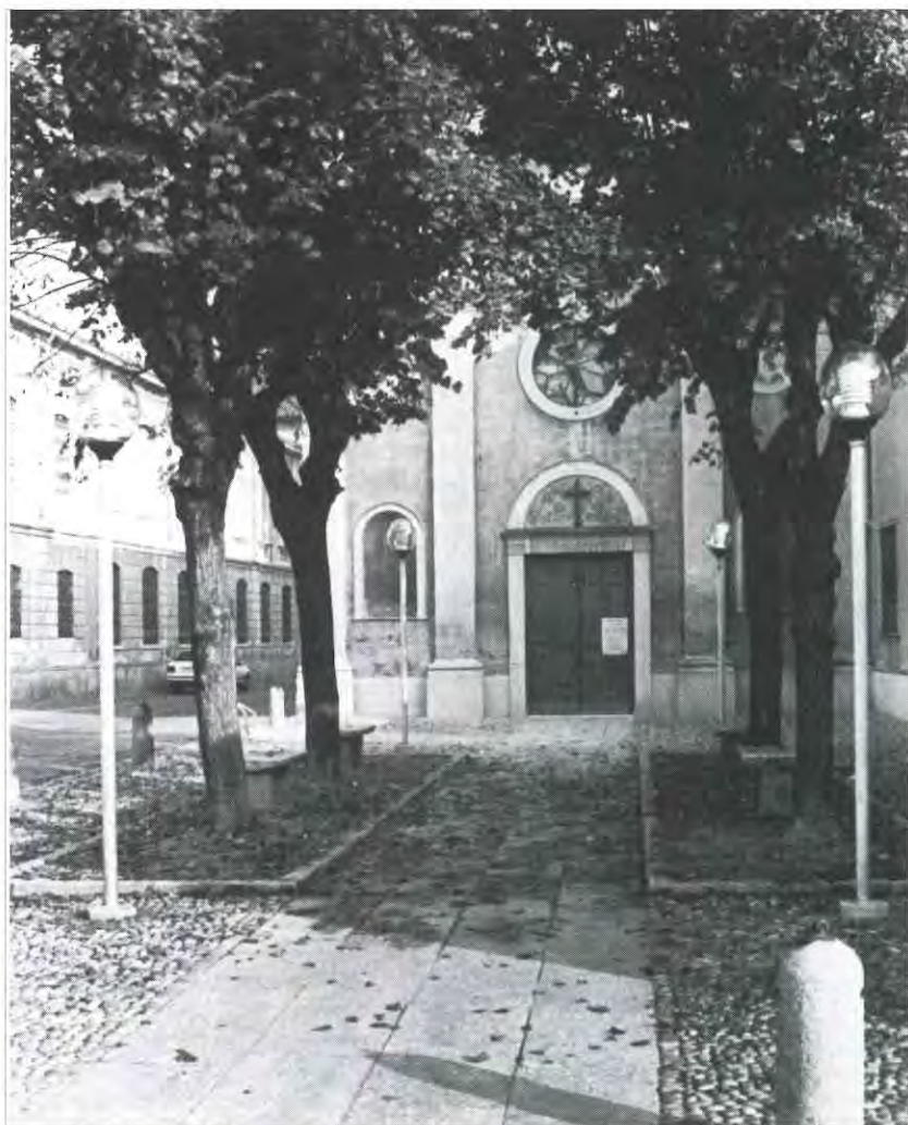
Chiesa di Santa Croce - realizzazione del nuovo sagrato.
