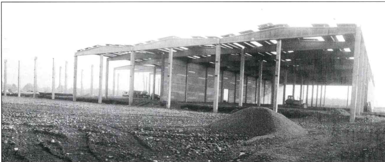
Nuovo PIP zona "Bruciate" - un capannone in fase di costruzione
