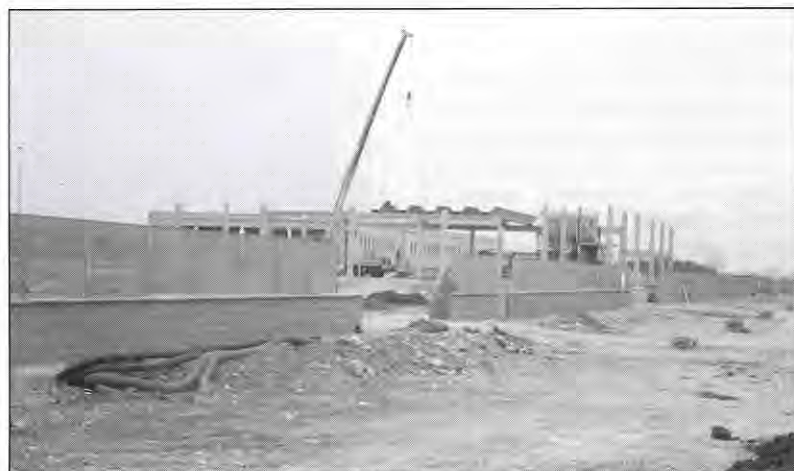
Opere di urbanizzazione - Ampliamento del P.I.P.
