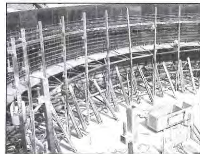
7. nuovo depuratore comunale - costruzione di un sedimentatore
