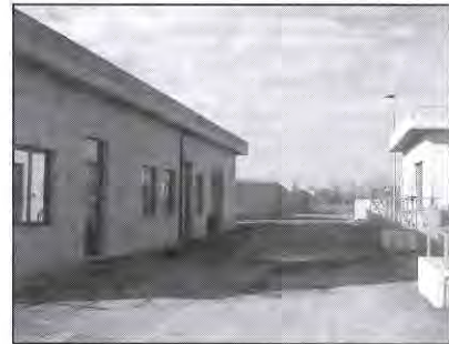
8. nuovo depuratore comunale - locale ufficio, laboratorio e sala macchine.
