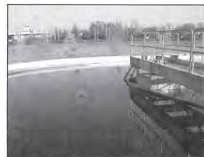
4. nuovo depuratore comunale - sedimentatore 2.
