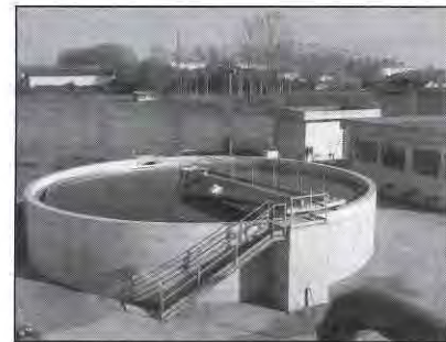
5. nuovo depuratore comunale - vista interna sedimentatore
